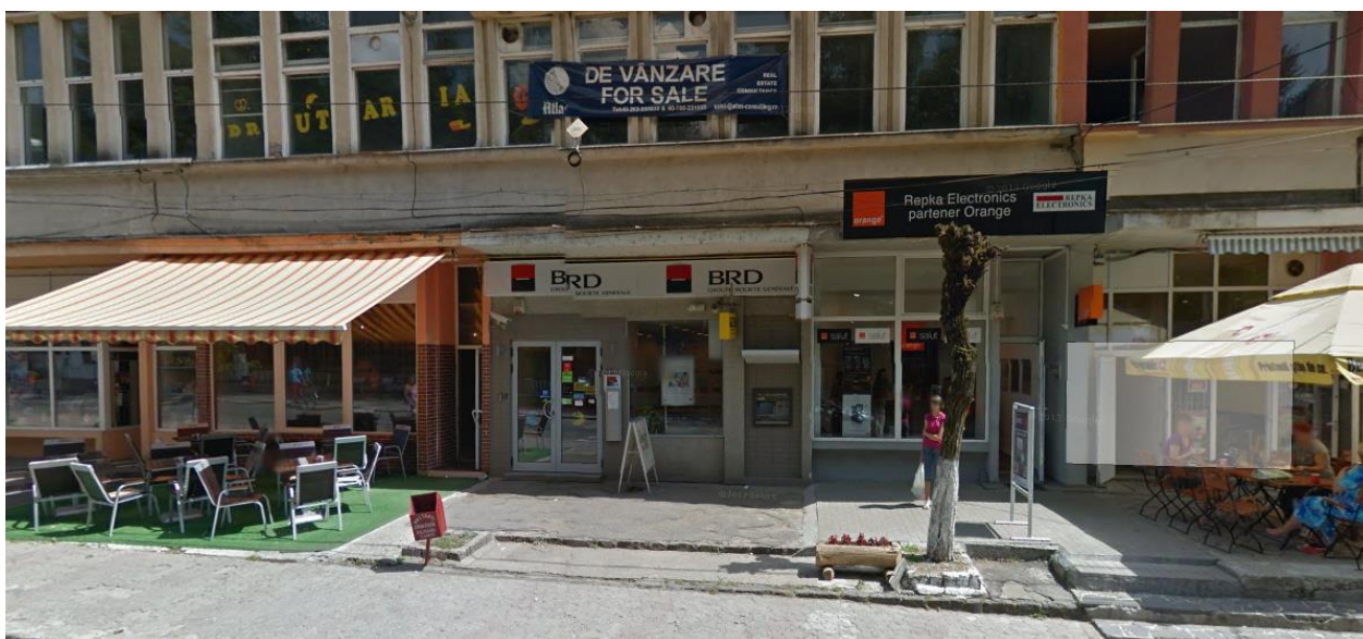
FOTO: Sucursala BRD Cavnic, Strada 22 Decembrie, nr. 20, Cavnic
