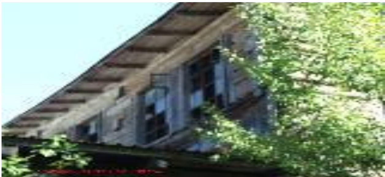
FOTO: Flotația de metale neferoase oraș CAVNIC, Str. Flotației 1A 1810 – 1820
