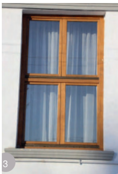
Exemplu tâmplărie geam. Fereastră nouă din lemn care păstrează proporțiile, materialul și culoarea ferestrelor tradiționale. Sursa : Ghid de arhitectură pentru încadrarea în specificul local de mediu rural Țara Chioarului
