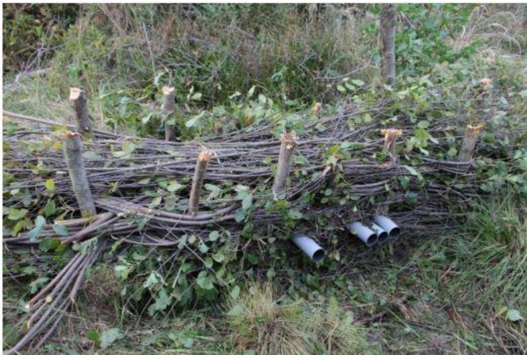
Figură 1 – Exemplu de stăvilă mixt executat în sitului ROSCI0112 Mlaca Tătarilor
