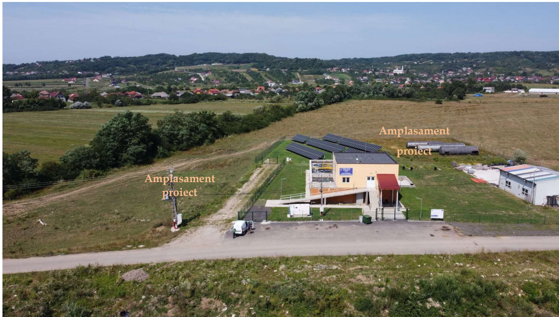
Fig. 5-2 Privire de ansamblu asupra amplasamentului proiectului și a facilităților deja existente pe parcela de teren din care face parte, respectiv CF nr. 53188. Sursa: fotografie din arhiva Primăriei Fărcașa, 2023
