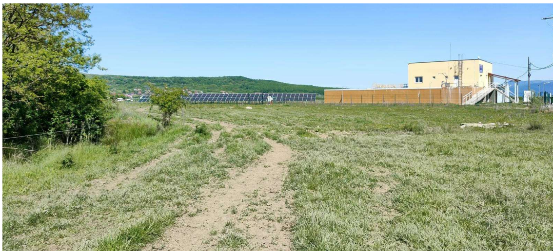
Fig. 5-3 Vedere dinspre colțul de S al parcelei către N: partea de S a amplasamentului proiectului (teren neîngrădit), după care urmează stația de epurare și centrala fotovoltaică existentă
