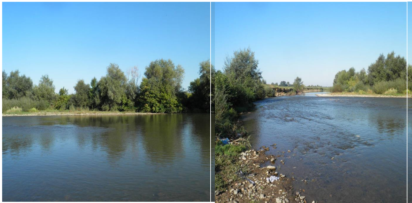
Foto nr. 3 Amplasament conductă transport Bozânta în zona de subtraversare a râului Lăpus
