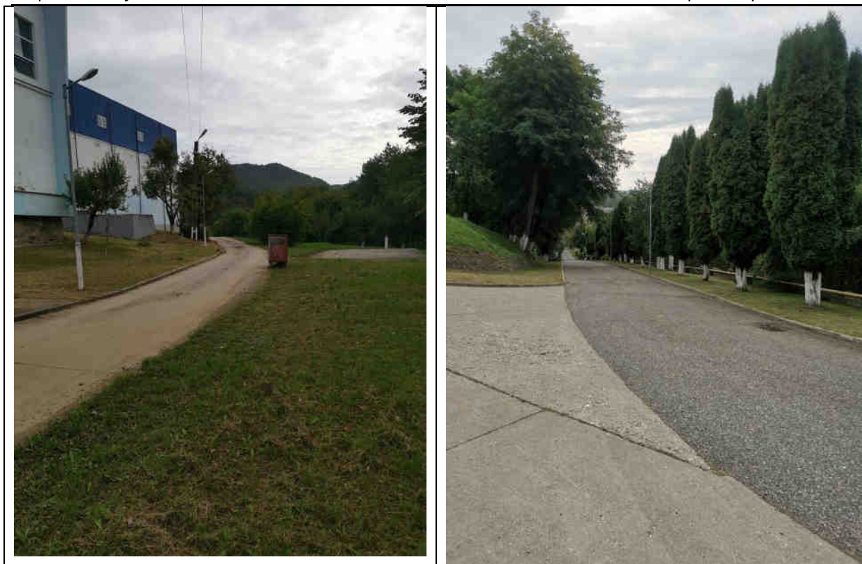
Foto nr. 5 Traseu conducta de transport apa (Gospodaria de apa Baia Mare)
