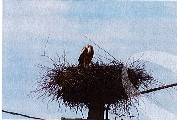
Figura 162/Anexa 2. Conductorii electrici de pe stâlpii de medie tensiune (D02.01.01 linii electrice și de telefon suspendate) prezintă pericolul de electrocutare asupra unor păsări de interes
